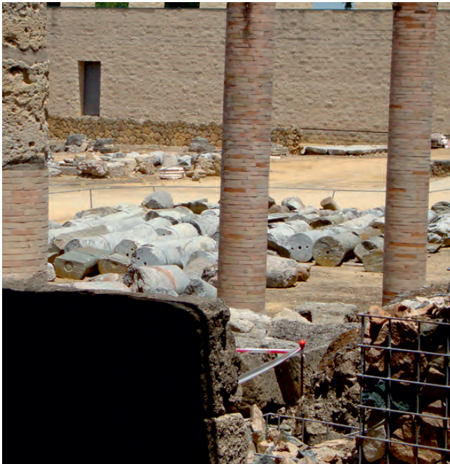
Fig. 80. Detalle de una columna formada por tambores en el teatro de Segobriga , donde se aprecia el hueco para encajar la pieza superior.
