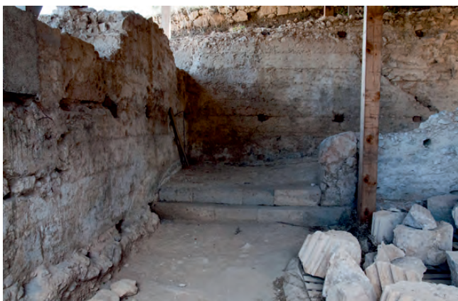
Fig. 70. Muro de opus incertum o mampostería con acabado resaltado de juntas, preparado para quedar visto, en el teatro de Regina .
