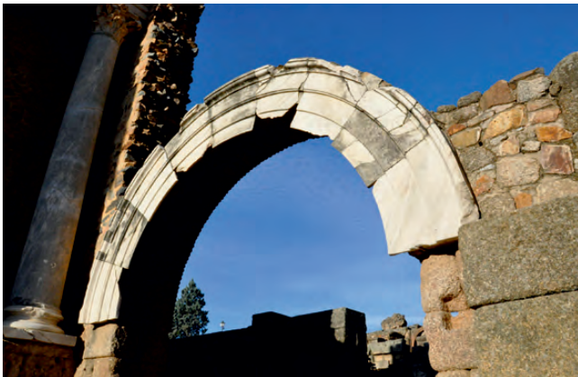
Fig. 76. Muro de escena del teatro de Clunia , donde se aprecian los mechinales para un andamio de báscula con almojayas pasantes.
