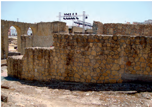
Fig. 67. Detalle de un sillar del muro del pulpitum , en el teatro de Baelo Claudia , con perforaciones para las zarpas que se dejaron porque el elemento iba a ser revestido.
