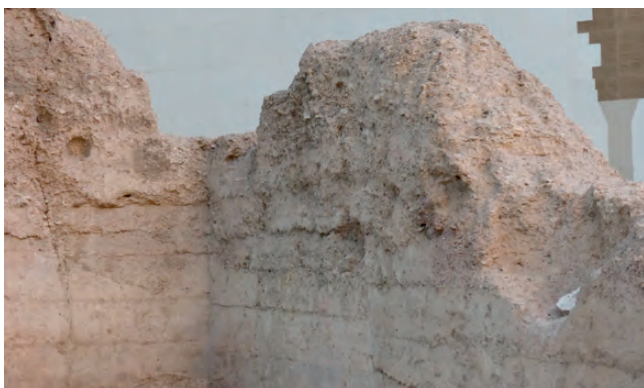
Fig. 73. Muro de opus vittatum o sillarejo con refuerzos de sillaría en el teatro de Baelo Claudia .
