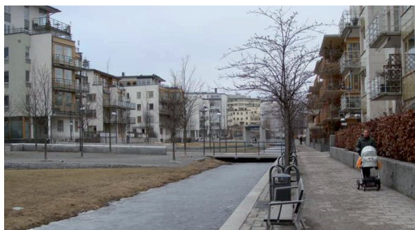
Figura 3.4.12.: Vista del principal eje interior ajardinado que se desarrolla en paralelo al frente de agua y que recoge parte de la actividad principal de relación y recreo de la población. Imagen tomada en marzo cuando la vegetación aún permanece bajo condiciones climáticas adversas (archivo autores).
