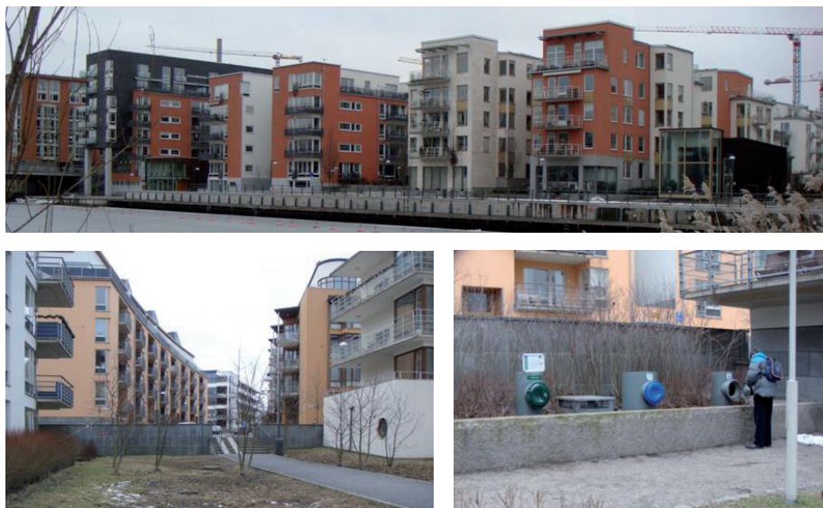
Figura 3.4.11.: Vistas de la evolución de las obras. En la parte superior aparecen los bloques abiertos (70x100m) hacia uno de los brazos de agua que rodea la actuación en los que dominan las 5 plantas y destaca a la derecha de la imagen uno de los elementos de cierre del frente, se trata de edificios menores con uso comercial. En la parte inferior aparece un paso peatonal entre bloques y a la derecha el sistema exterior de recogida selectiva de residuos (archivo autores).
