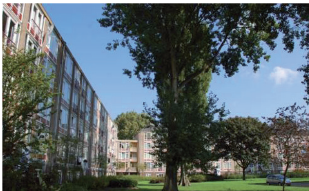
Figura 1.4.14.: Panorámica de la ampliación oeste de Amsterdam (archivo autores).
