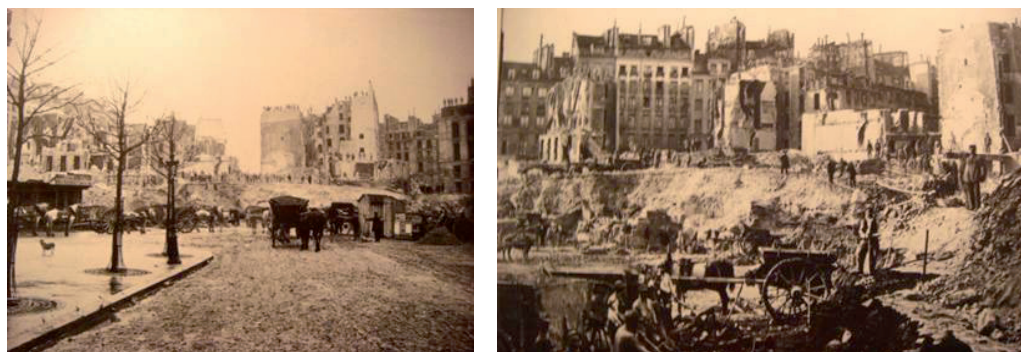
Figura 1.2.3: Fotografías antiguas de los trabajos de apertura de los bulevares en París, recogidas por P. Pinon.
