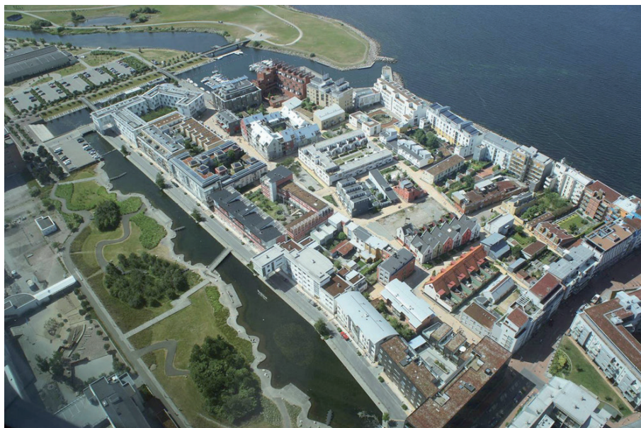
Figura 3.4.19.: Vista oblicua de la zona Bo01. Ayuntamiento de Malmö.
