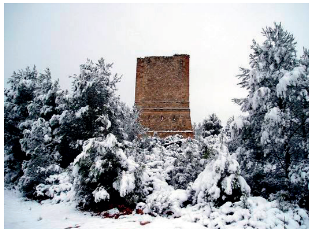
| 10 | Torre telegràfica de Bunyol. Torre telegràfica de Bunyol . Fuente/Font: Manuel Escobar García-Dotor. http://telegrafiaoptica.wikispaces.com/Alto+de+la+Portilla
