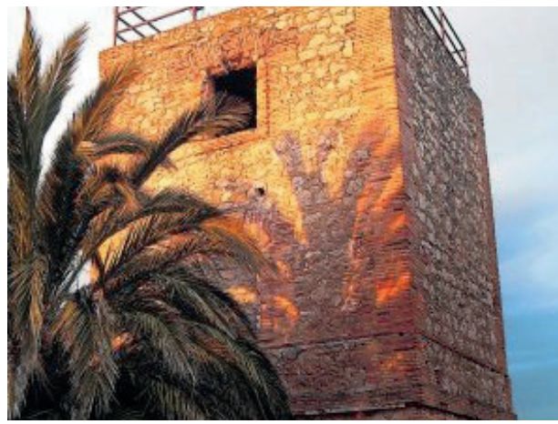
| 12 | Torre telegràfica de Chiva. Torre telegràfica de Xiva . Fuente/Font: Vicente Lladró. Las Provincias. 25 de enero de 2014.
