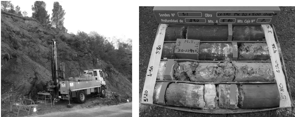
Fig.1.1: Izquierda: Sondeo a rotación. Derecha: Caja Portatestigo de PVC, donde se coloca el terreno extraído del sondeo.
