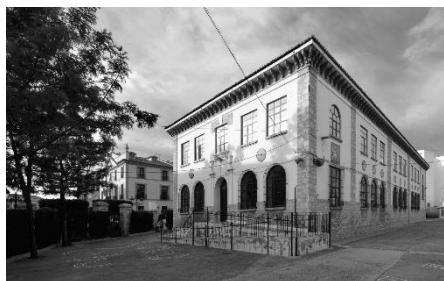
Estado actual del grupo Alfonso XIII desde la calle y desde el patio escolar con la fachada de aulas. C. Gómez.
