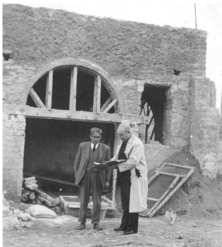
El arquitecto en visita de obra. AJC.
