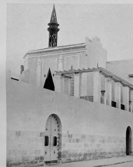
181-183 Arch.: José Cort Boti, Alicante
