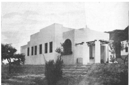
Hotel, vista suroeste. Arquitectura , no. 114.
