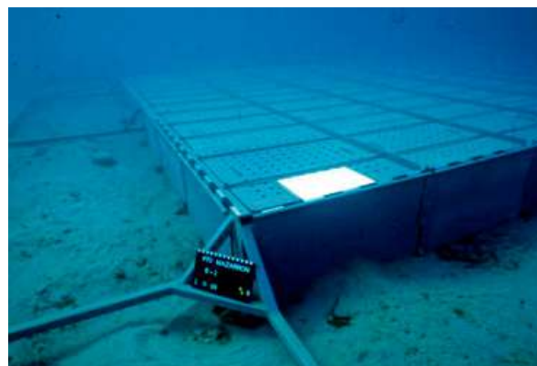
Estructura metálica para la protección del Mazarrón II. ©UNESCO.
