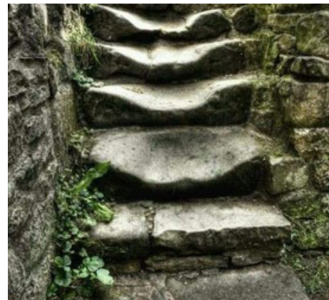
Erosión mecánica (PF6) Mechanical Erosion (PF6)
