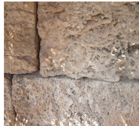
Alveolización (PF12) Alveolization (PF12)
