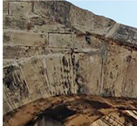
Acanaladuras (PF8) Grooves (PF8)
