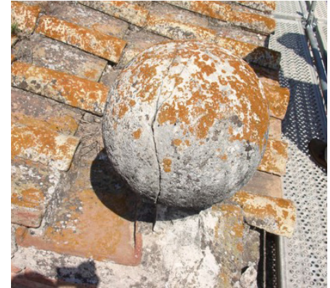
Incrustación (PB3) Incrustation (PB3)
