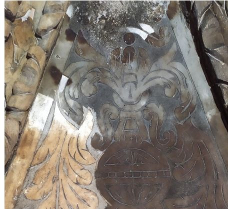
Manchas de grasa (RC2) Grease stains (RC2)
