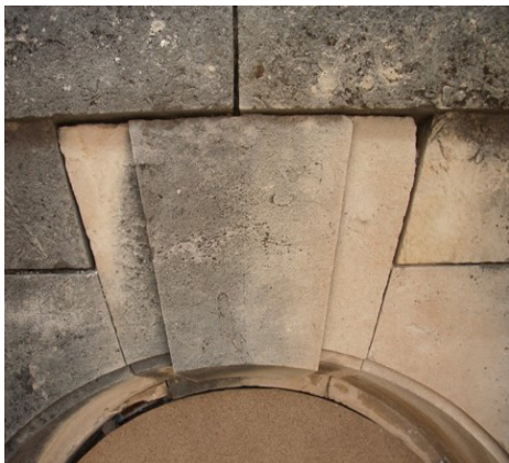
Vaciado de juntas (PF4) Joint emptying (PF4)
