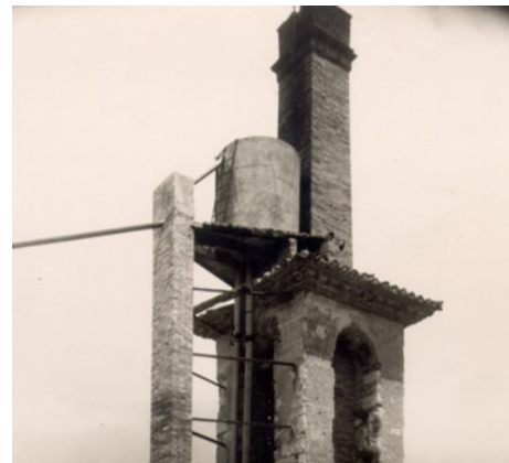
Elementos impropios (PA3) Improper elements (PA3)
