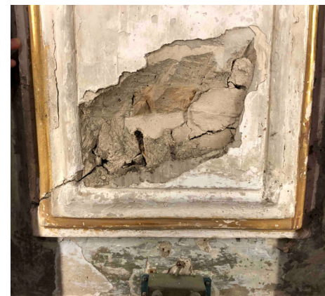
Pérdida de superficie (lagunas) (RF6) Loss of surface material (gaps) (RF6)
