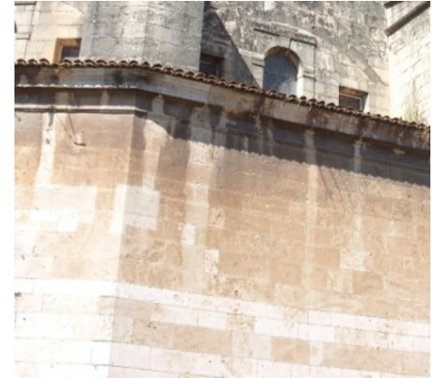
Lavados (PF9) Material dragging (PF9)
