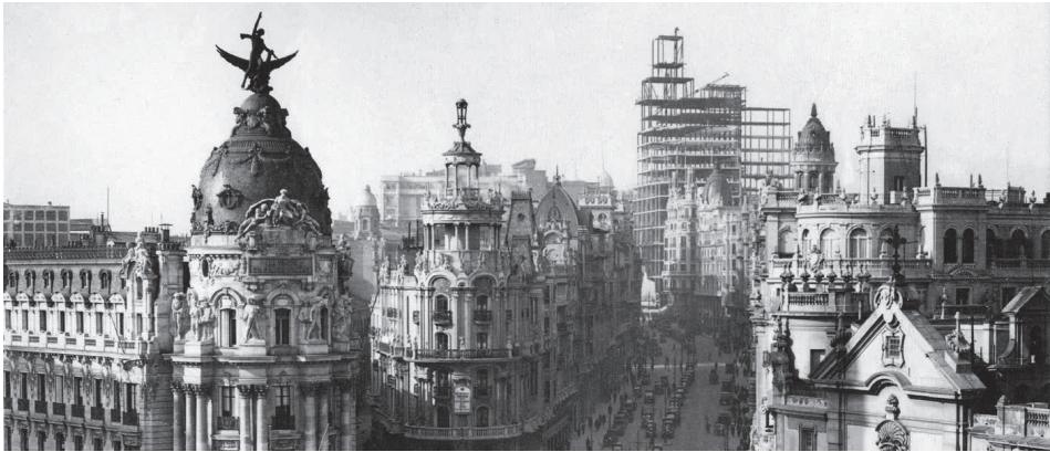
Figura 62. Al fondo, el edificio de la Telefónica en la Gran Vía de Madrid en proceso de construcción, 1926-1930. En primer plano, la cúpula del edificio de La Unión y el Fénix.
