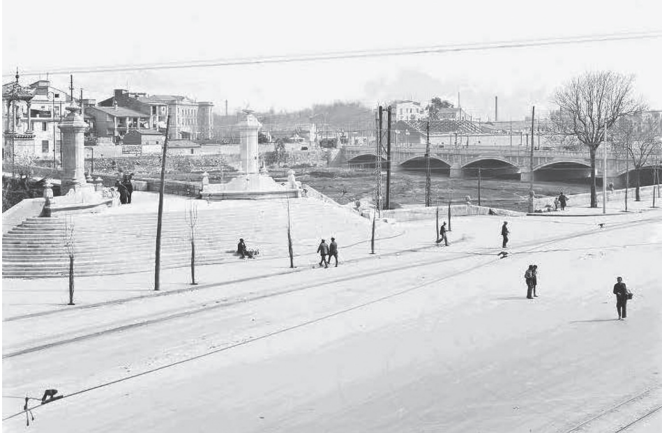
Figura 22. Escalinatas construidas para la peatonalización del puente del Mar sustituyendo las rampas originales, según el proyecto del arquitecto municipal Javier Goerlich.
