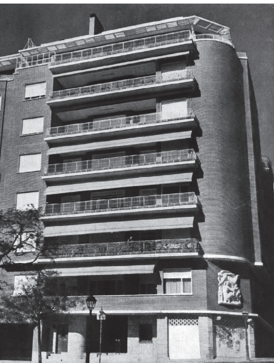
Figura 98. Viviendas en la calle Juan Bravo de Madrid (1954).
