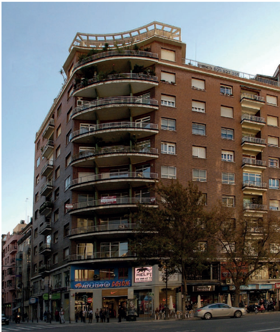
Figura 90. Edificio Ripoll en la calle Xàtiva esquina a Ruzafa proyectado y construido por el arquitecto Javier Goerlich Lleó entre 1956-1958.
