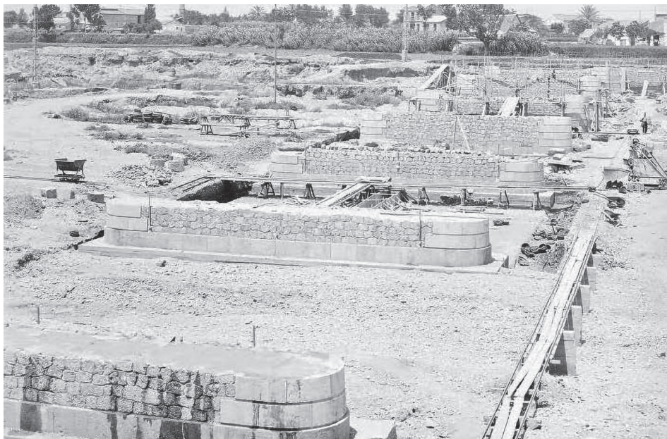
Figura 20. Construcción de las pilas del nuevo puente de Aragón, según proyecto del ingeniero Arturo Monfort, perteneciente a la Confederación Hidrográfica del Júcar, entre 1927 y 1933.
