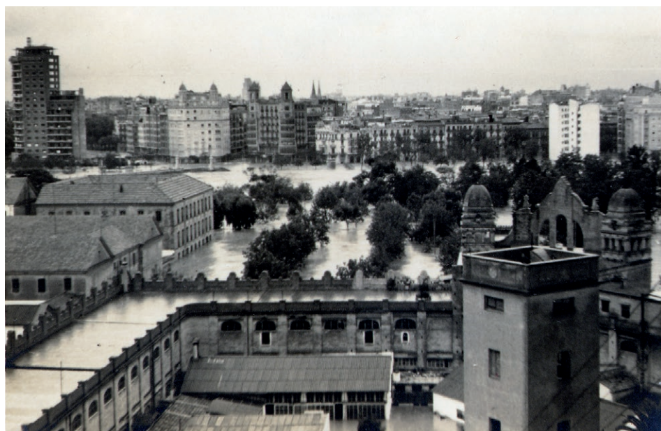
Figura 27. La Torre Valencia y la riada de octubre de 1957. En primer plano el antiguo Bañerío de la Alameda y a la izquierda los cuarteles de la Alameda, al fondo a la izquierda se distingue la Torre Valencia en construcción.
