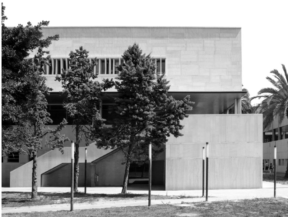
Remodelación y ampliación de la ETSA-UPV. Valencia. 2000
