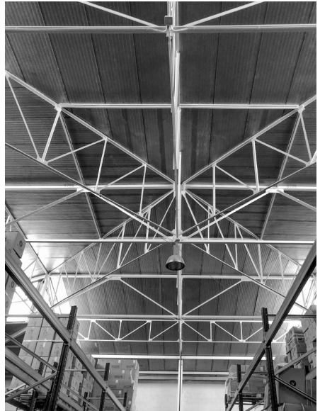
Espacio central de la fábrica de Hilaturas Climent.1972
