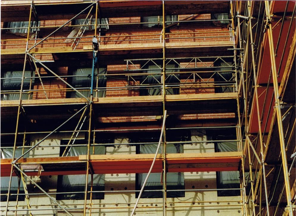
**Foto 1. Cerramiento con hoja exterior corrida por delante de la estructura**
