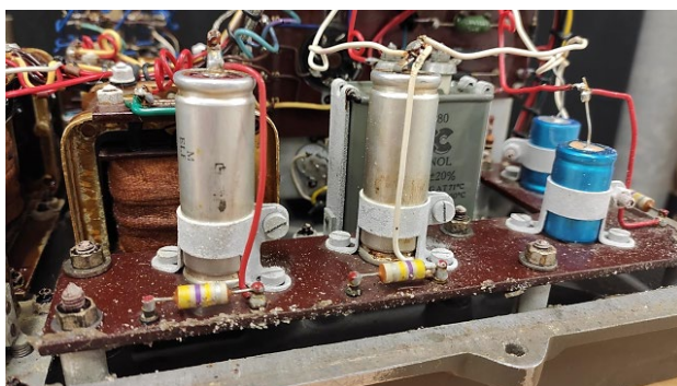
Fig. 9. Detalle del estado inicial de los componentes electrónicos.
