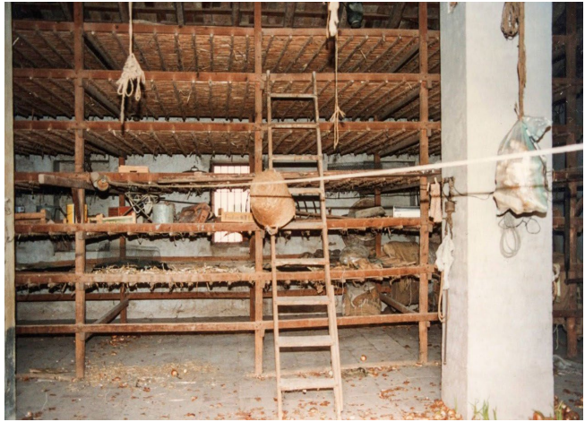
Fig. 7. Estructura de cañizos en sucesivas alturas practicables a través de pasadizos.
