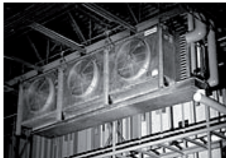
Figura nº 2.8. Vista de un evaporador de aire
