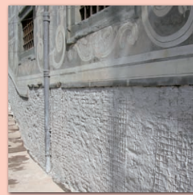
Realización del revoco deshumidificante
