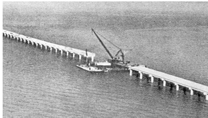
(a) Este procedimiento requiere emplazamientos accesibles por carretera o cauces navegables, para facilitar el transporte de las vigas.
