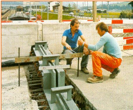
Detalles de ejecución de juntas con perfiles de expansión:
