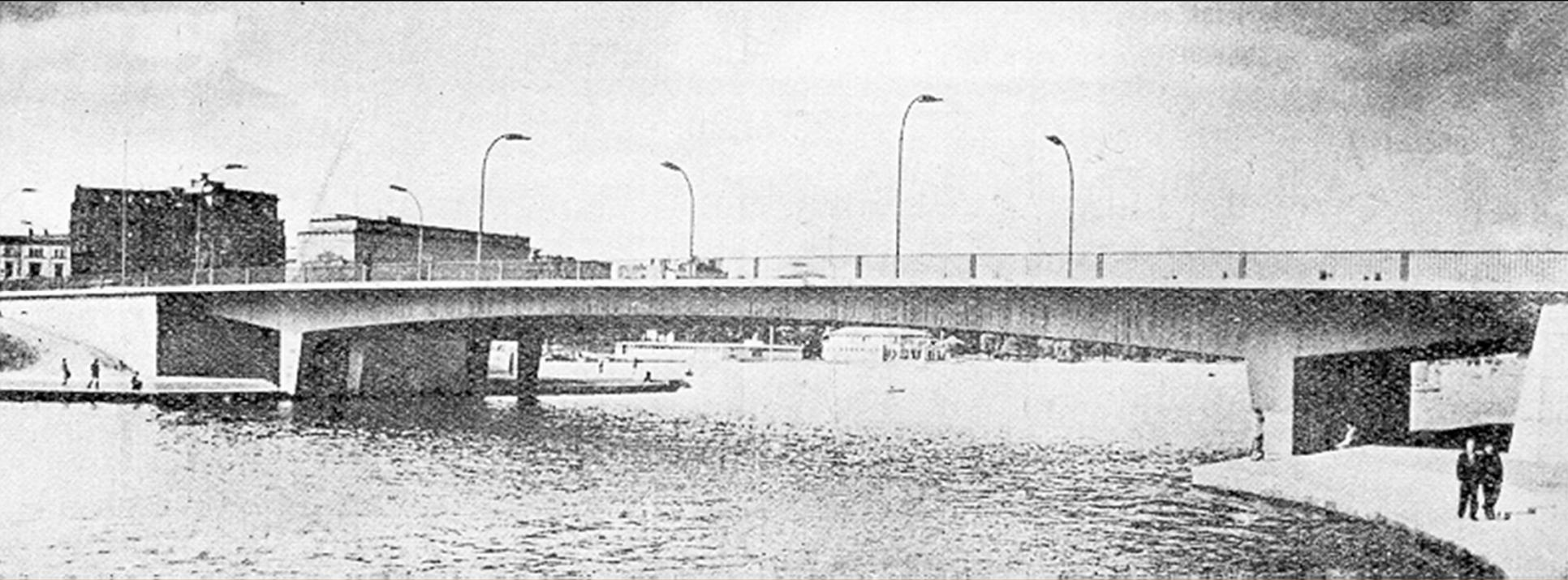
▪ Ejemplo: *puente Lombard*, sobre el río Alster (1953, DYWIDAG, 60.32 m)
