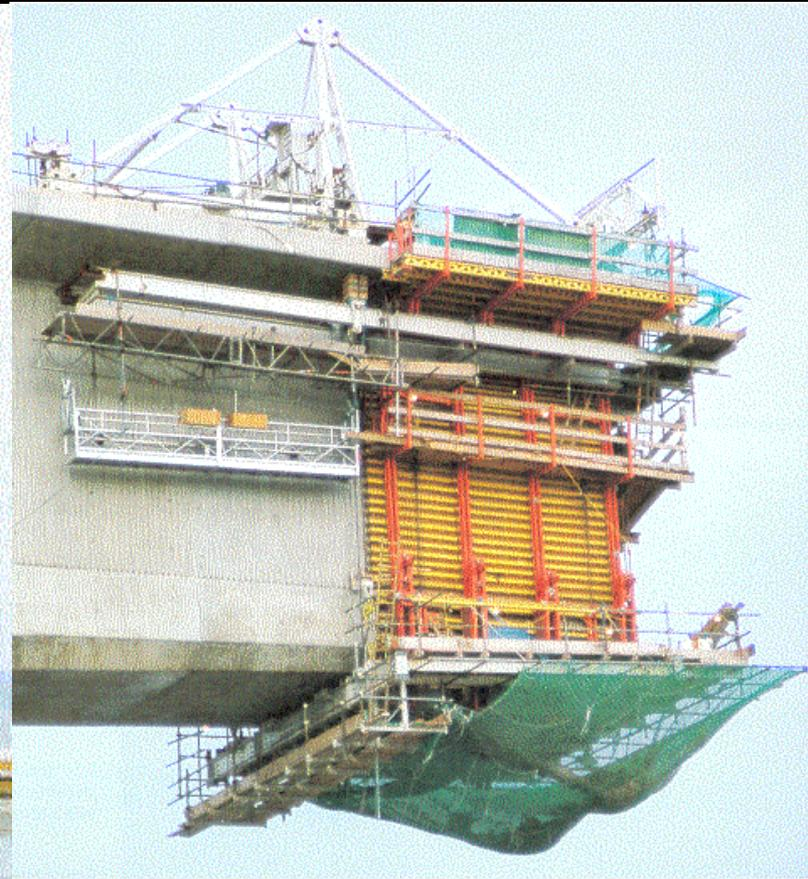
▪Ejemplo de cajón hormigonado in situ en voladizo puro: el *Skye bridge* (Escocia, 1995, 250 m de luz)
