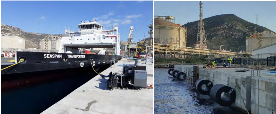
Fig. 10 Resultado final de los trabajos. Fuente: SATO (2020)
