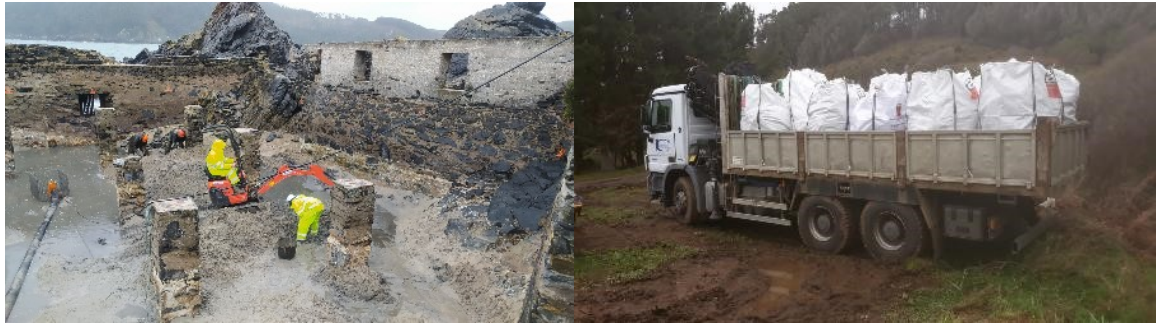
Fig. 6 Dragado con mini-pala y transporte residuos a gestor. Fuente: MITECO (2022)
