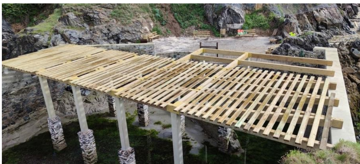
Fig. 10 Reconstrucción de cubierta de madera. Fuente: MITECO (2022)
