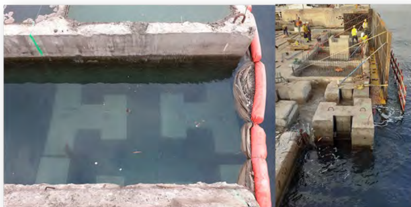
Fig. 5 Juntas con bloques prefabricados. Fuente: SATO (2020)
