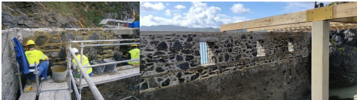
Fig. 7 Repicado y recebado con mortero de muros y restauración de rejjas. Fuente: MITECO (2022)
