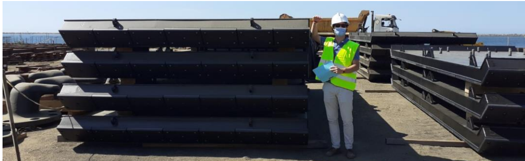
Fig. 13 Escudos de las defensas acopiados en obra
