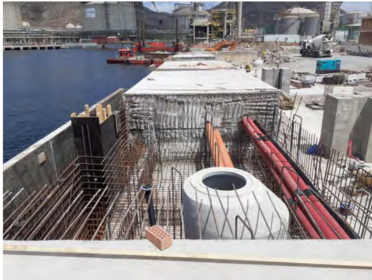
Fig. 6 Superestructura sección 1. Fuente: SATO (2020)
