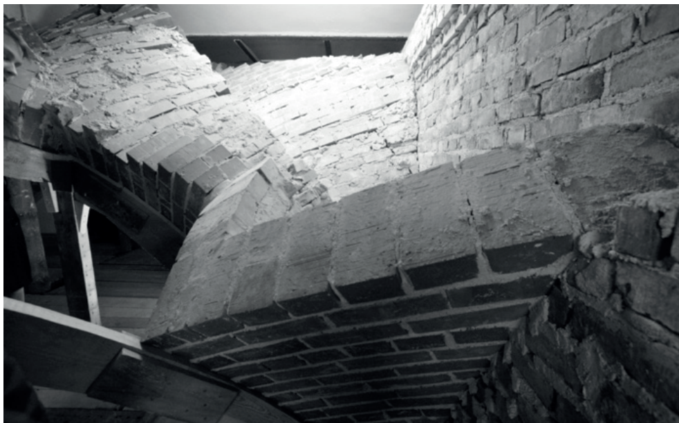
Figura 2. Bóveda en construcción dirigida por David Wendland como experiencia del sistema, en Meissen (Alemania).
